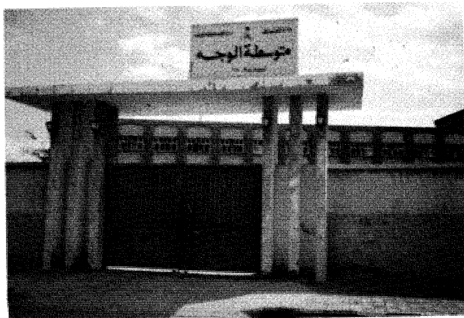
التعليم : مبنى المدرسة المتوسطة
